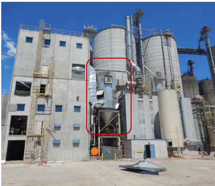
Figura 16. Lado sur del Molino D. A medida que el superintendente (punto naranja) estaba evacuando el molino, corrió bajo el filtro de grano seco (caja roja) cuando una explosión lo derribó.
