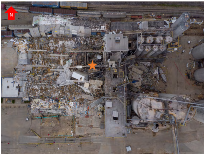
Figura 17. Ubicación aproximada (estrella dorada) de una explosión después del colapso de los edificios de la planta.
