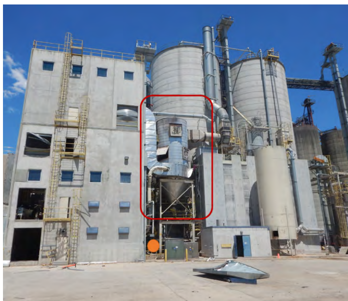
Figura 16. Lado sur del Molino D. A medida que el superintendente (punto naranja) estaba evacuando el molino, corrió bajo el filtro de grano seco (caja roja) cuando una explosión lo derribó.
