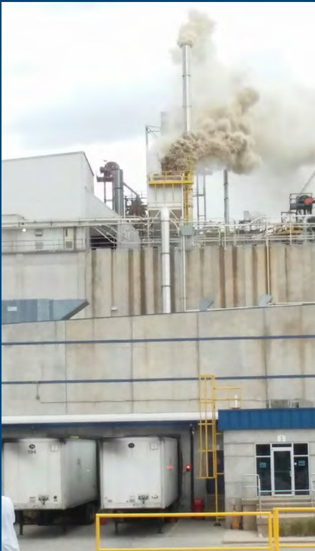
Figura 14. Imagen tomada por un trabajador de Didion del incendio del 29 de mayo de 2017. La estructura en el techo del edificio emanando humo es un colector de polvo.
